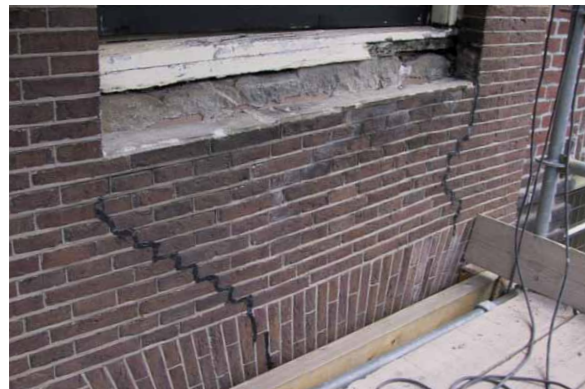
Verzakkingen als gevolg van droogte
