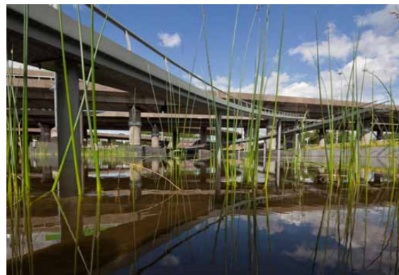
Tijdelijke waterberging onder het Kleinpolderplein
