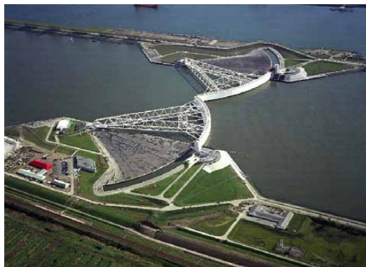
Maeslantkering in de Nieuwe Waterweg
