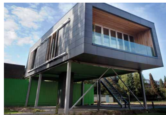
Concept House Village Heijplaat: floodproof bouwen
